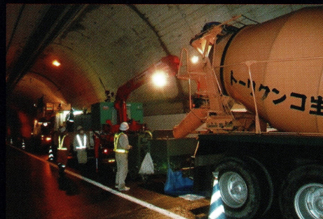
アジテータ車による施工
